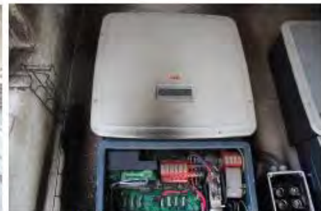
De kap van de linker omvormer verwijderd
