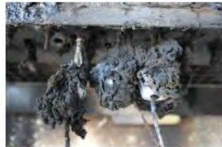
Connectoren onder aan de omvormer
