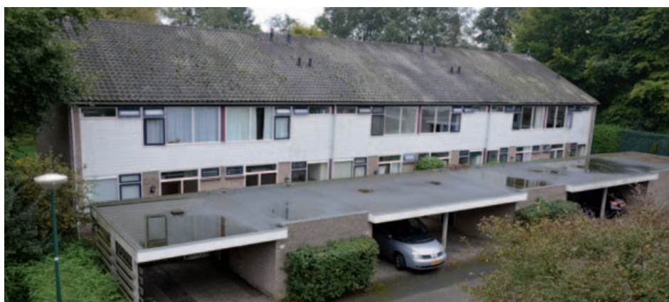
De woningen in Maarn oogden door de wandbekleding in de oude situatie massief. Het dak van de carports was doorgetrokken.
