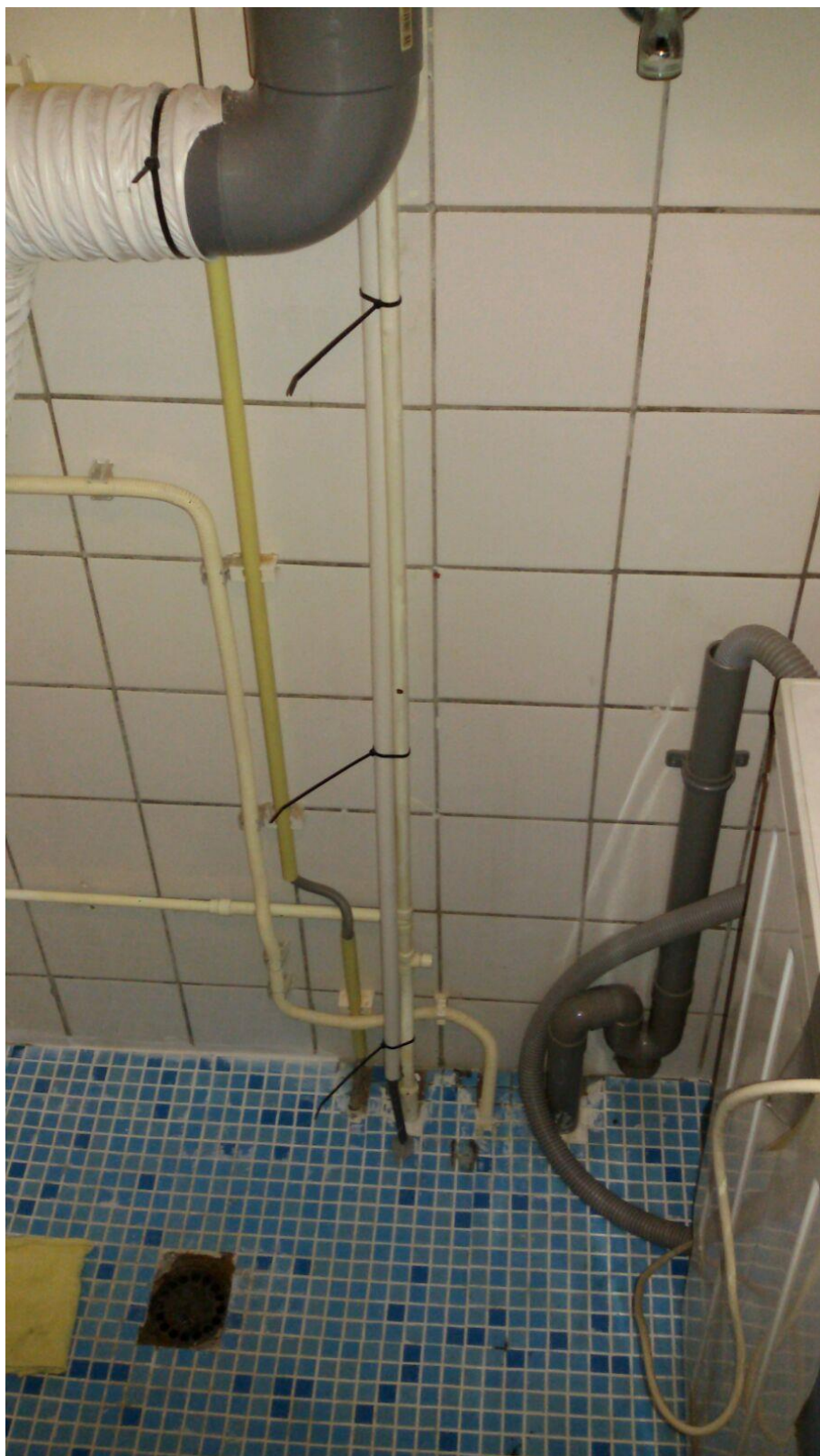
Kabels vast aan warm waterleiding. Afvoer geraakt dus bij douchen loopt water in de meterkast.
