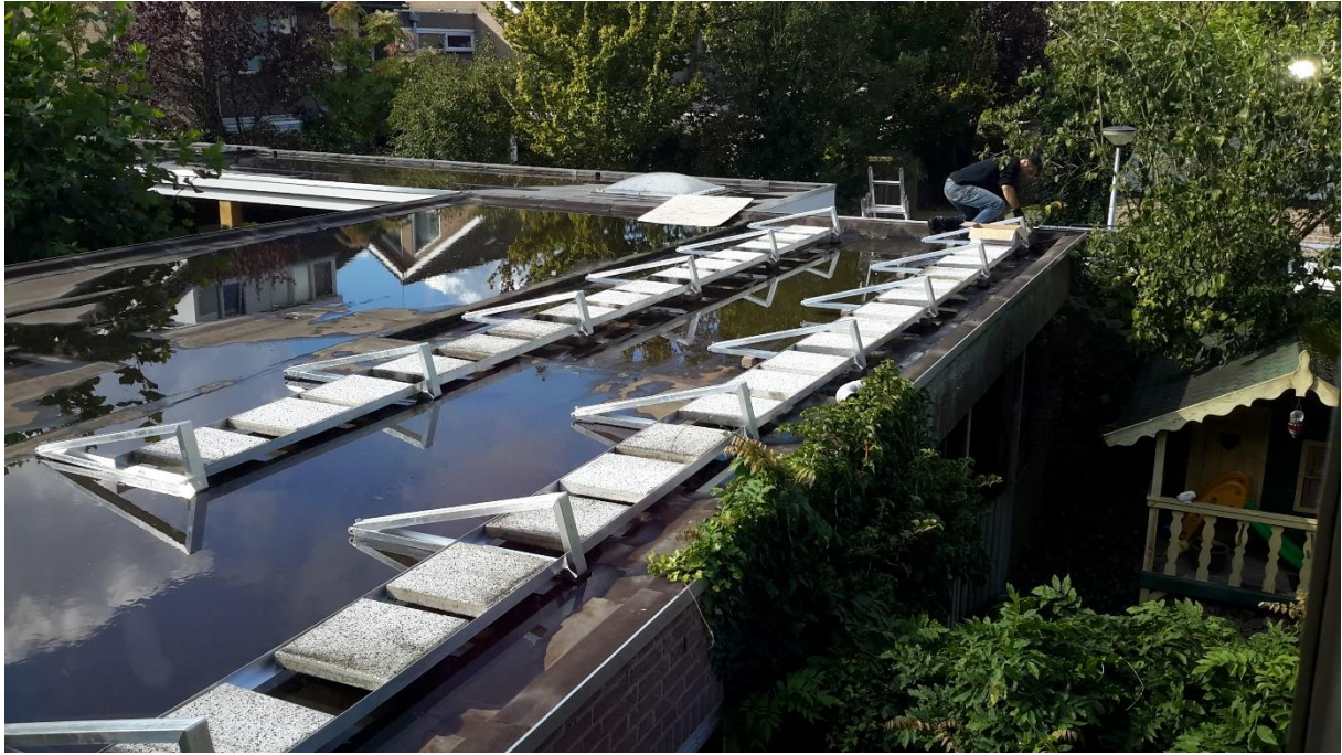
Door combinatie van water en zonnepanelen te zware dakbelasting
