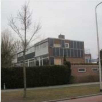
Figuur 3: Voorbeeld van zonnepanelen gemonteerd op een gevel (foto: Dirk van Baalen)
