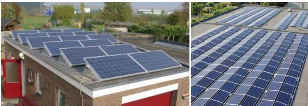
Figuur 2: Zonnepanelen op plat dak in "landscape" opstelling (links) en in "oost-west" opstelling (rechts).
