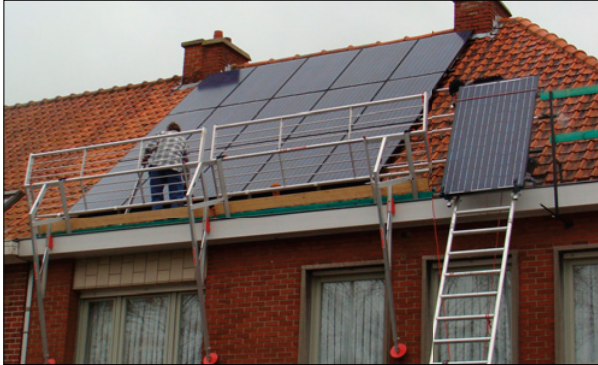
Figuur 6.7: De panelen worden geïnstalleerd
