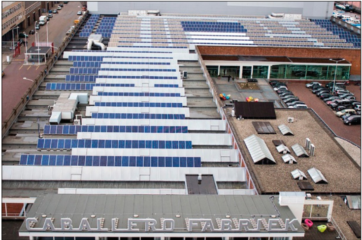
Figuur 4.8: Zonnepark Nederland Caballero Fabriek Den Haag (pro- ject: Solar Green Point)
