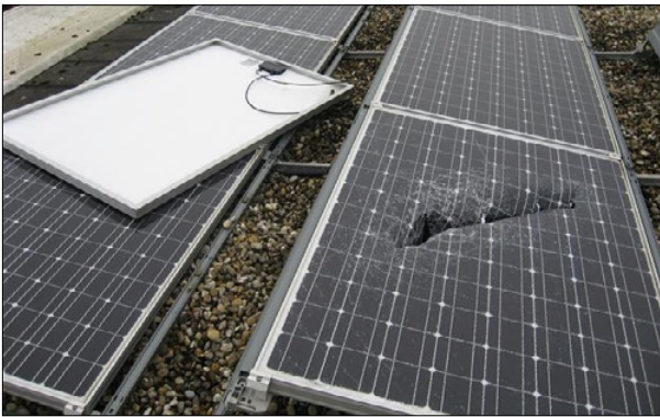
Figuur 6.4: Stormschade veroorzaakt door ondeugdelijke installatie
