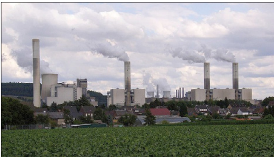
Figuur 4.3: Bruinkoolcentrale Frimmersdorf (author: Bodoklecksel)
