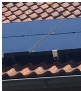
Figuur: panelen die niet goed zijn uitgelijnd (geen recht vlak)
