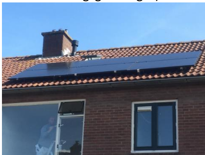
Figuur: panelen die niet goed zijn uitgelijnd (geen recht vlak)
